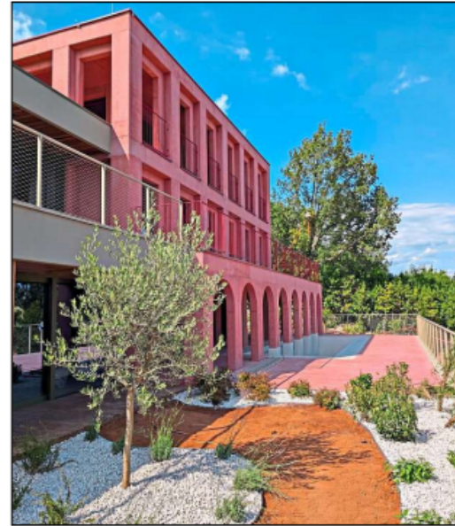
Ganz schön tricky war es, was sich Stararchitekt Idis Turato für das Eichberger-Projekt ausgedacht hat: roter Sichtbeton. Das gleichmäßig hinzubekommen, hat die bauausführende Firma durchaus gefordert.
